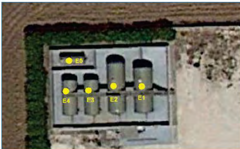
Fig. 14 –Vista dall'alto delle cisterne di stoccaggio. 17
